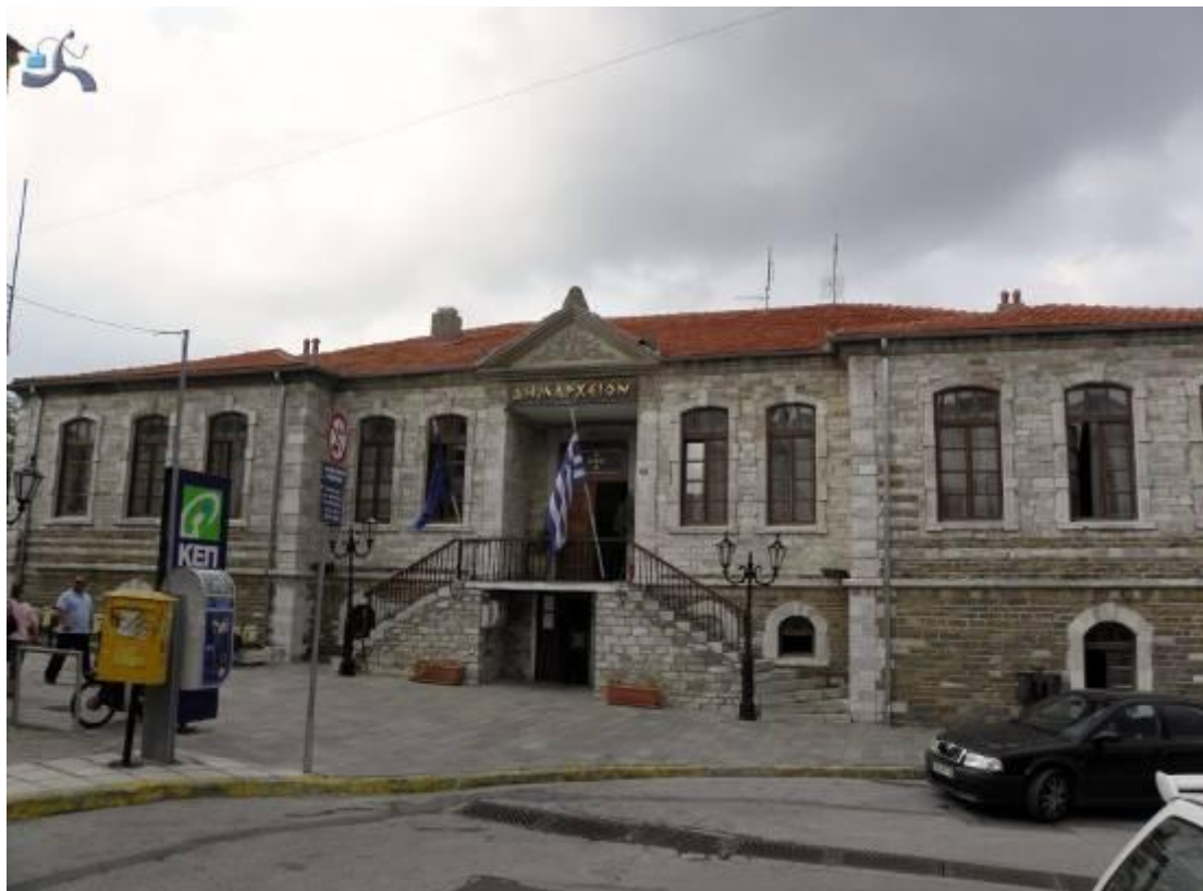
Σημείο εγκατάστασης περιφερειακού σημείου
