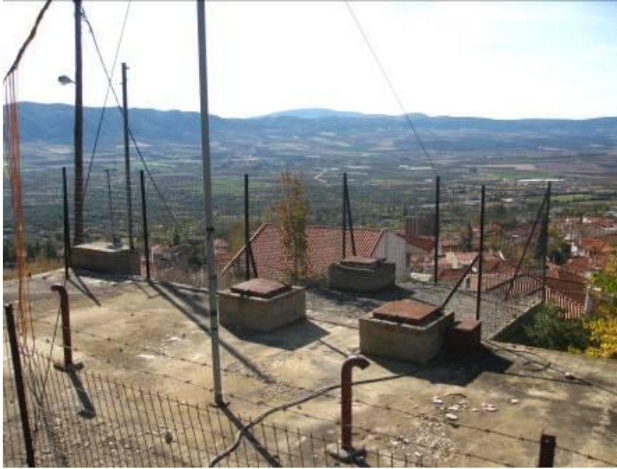
Σημείο εγκατάστασης δεύτερου περιφερειακού σημείου
