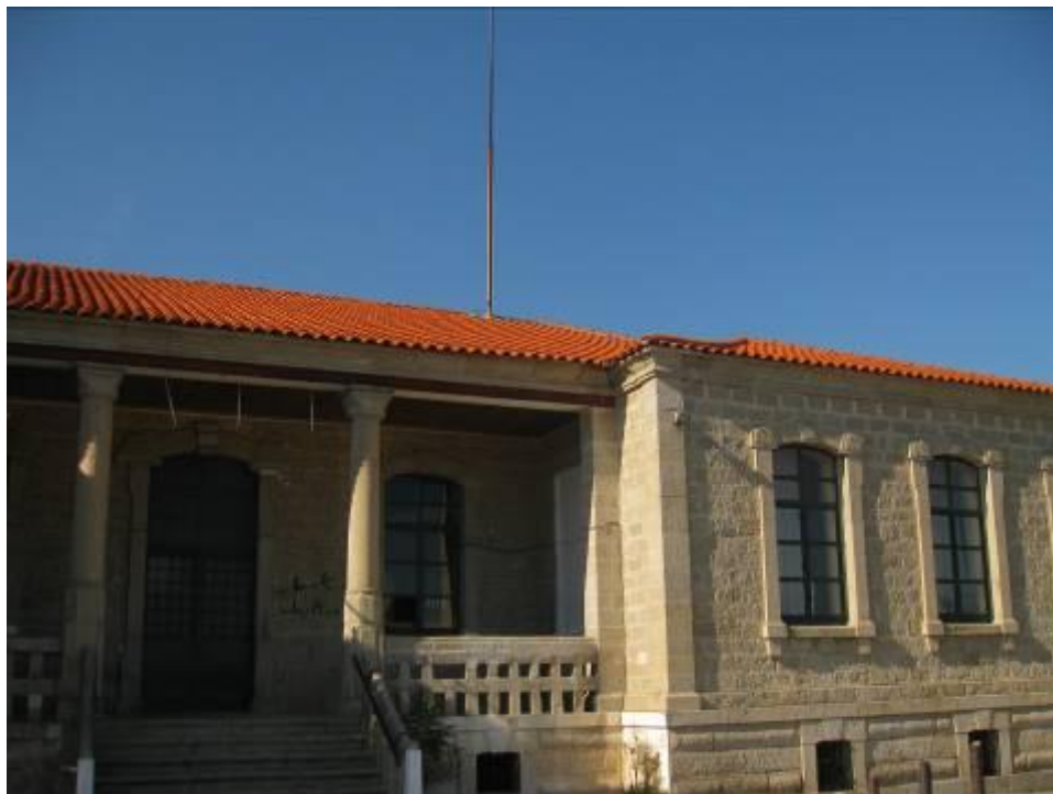
Σημείο εγκατάστασης περιφερειακού σημείου
