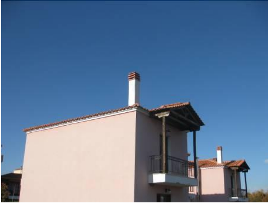
Σημείο εγκατάστασης πρώτου περιφερειακού σημείου
