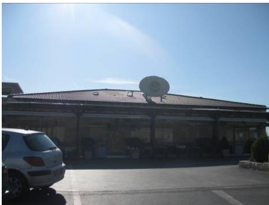
Σημείο εγκατάστασης πρώτου περιφερειακού σημείου
